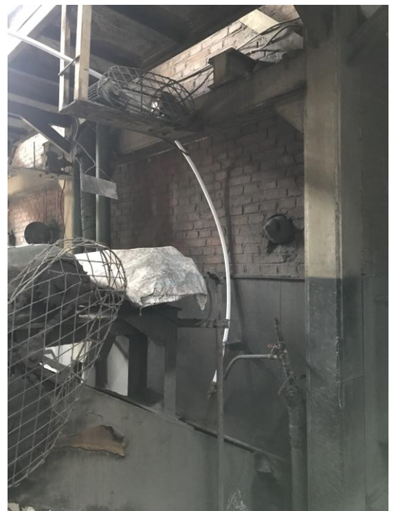
工艺废水回用冲渣
