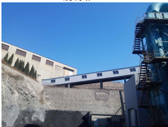
封闭的煤仓及封闭的上煤系统
