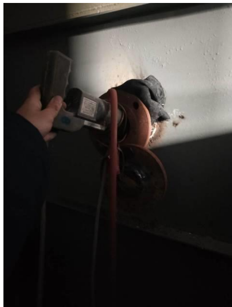
锅炉装置净化器前口
