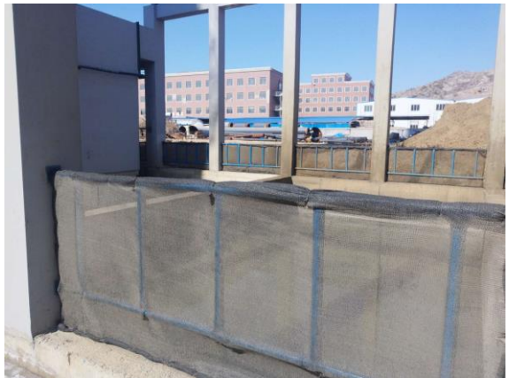
脱硫排水循环水池
