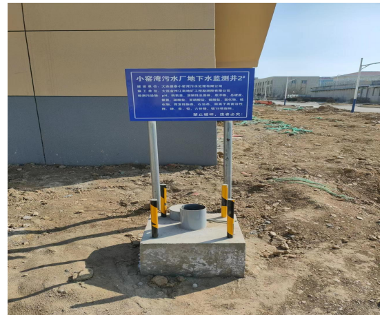
地下水监测井 2
