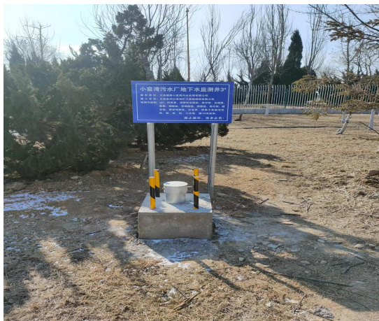
地下水监测井 3
