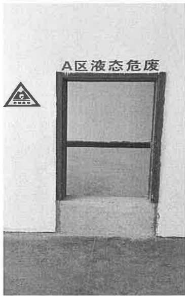
其他危废 A 区液态危废区
