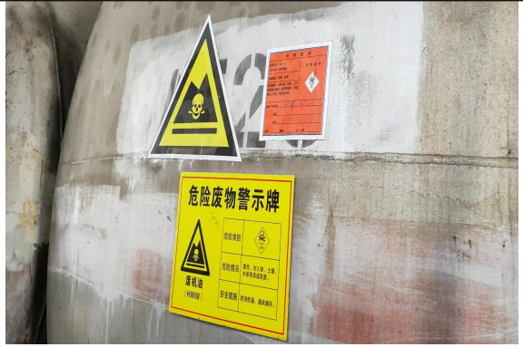
储油罐危险废物警示牌
