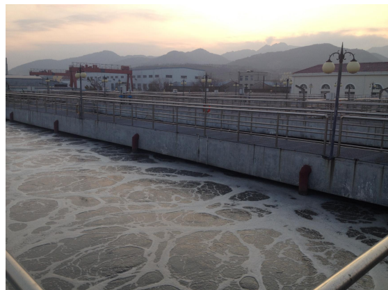
大连旅顺城市污水处理有限公司
